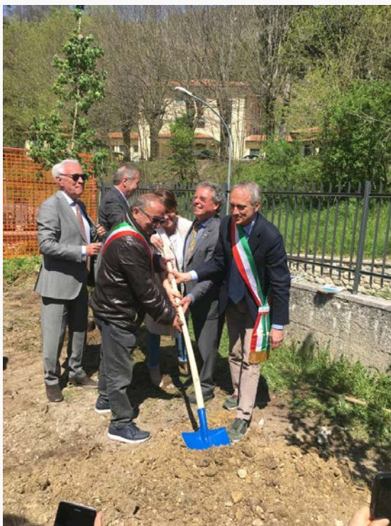
Prima pietra: il cantiere avviato ad Arquata del Tronto
