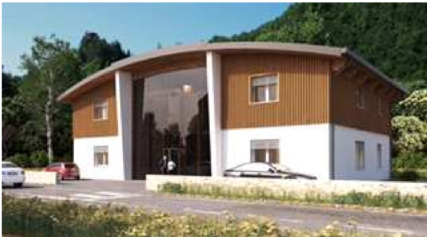
FRONTE VERSO LA STRADA
